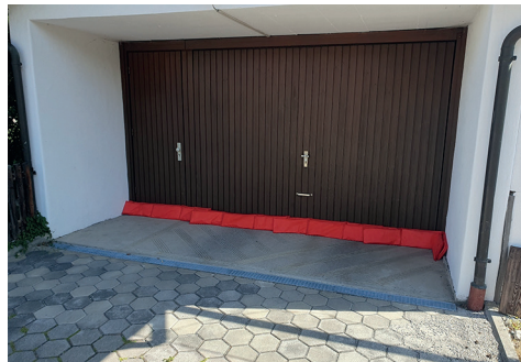
Starkregen-Sicherung Tiefgarage Staltacher Straße 72 Foto: Höhler
